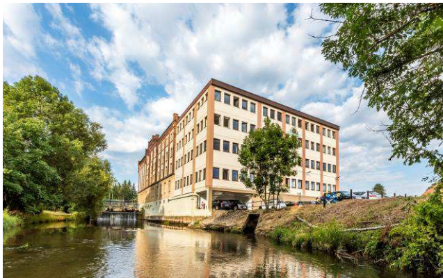
Título de la foto: La sede central de Neudorff en Emmerthal, Alemania, genera su propia electricidad
